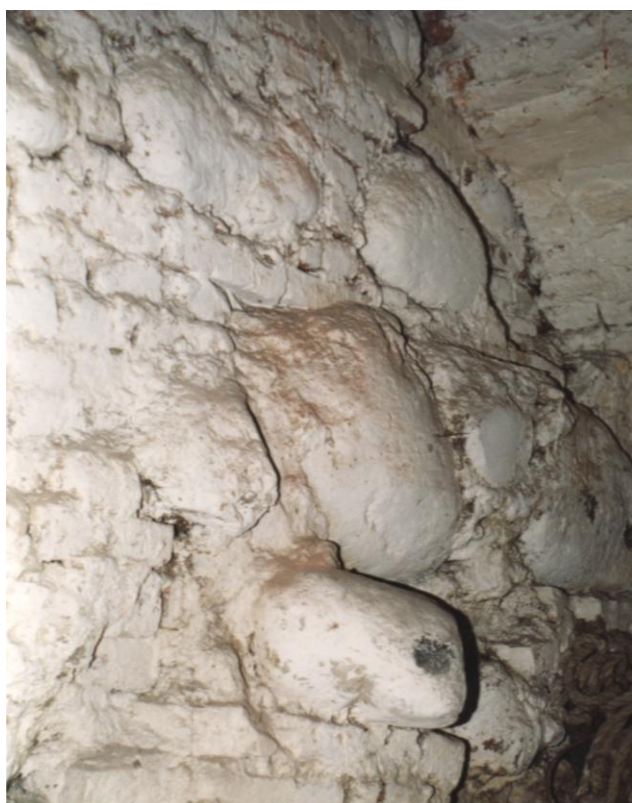
3 m grubości fundament rozebranej ściany wschodniej Bramy Klasztornej krypcie kościoła pojezuickiego. Fot. M. Sz.
