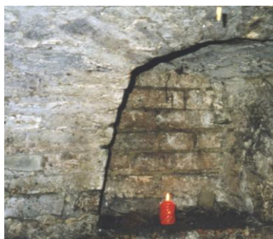
Fragment parchamu od strony wschodniej z okresu krzyżackiego z zamurowanym oknem przy ul . Murowej 24. Fot. M. K
