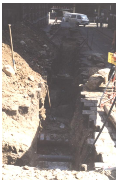
Wykop ziemny przy ul. Starorynkowej w 2000 r. Na całej jego długości jest fundament baszty. Fot. M. Sz.
