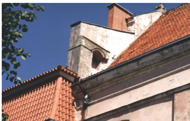
Widok na kalenicę dachu kościoła pojezuickiego od strony południowej z czytelnym dawnym oknem baszty bramnej. Fot. M. Sz.
