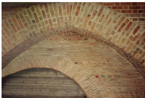
Przęsło mostu w Warszawie z podwójnym murem arkadowym analogicznie jak w Grudziądzu. Fot. M.Sz.
