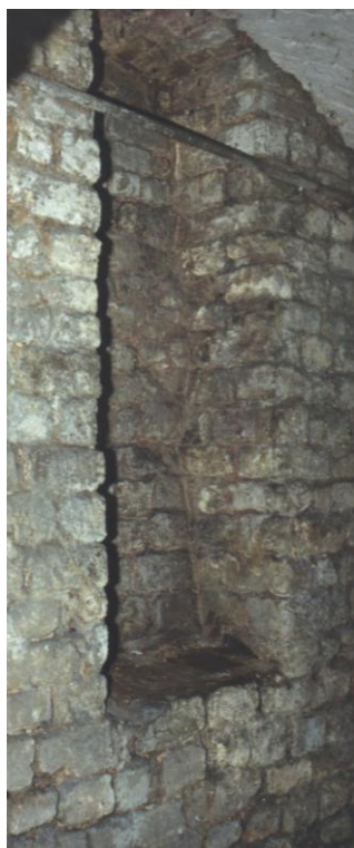
Fragment parchamu (międzymurza) z okresu przedkrzyżackiego. Jedna z dwóch zachowanych w jednej linii blanek muru obronnego w piwnicy kamienicy przy ul. Murowej 28. Fot. M. K. Kamienica ta znajduje się na północ od Bramy św. Chrystiana. Podobna blanka
