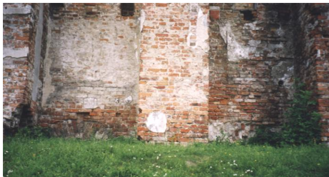
Zasypane wrota między przyporami Furty Gnojnej. Fot. M. Sz.
