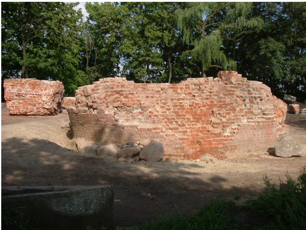
Ruiny wieży Klimek. Stan w 2006 r. Lico z cegły maszynowej, z przełomu XIX/XX w.
