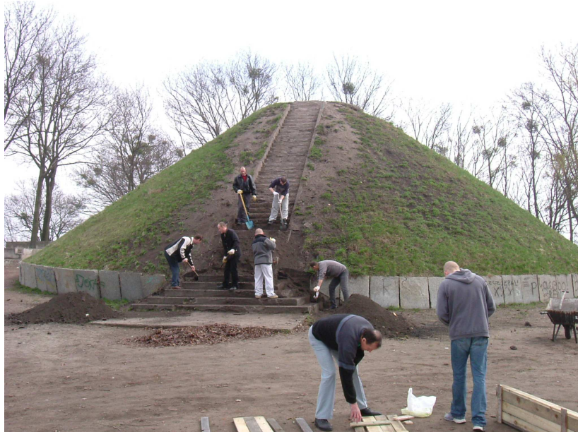
18.04.2006 r. Początek rozbiórki kopca. Fot. M. Szajerka
