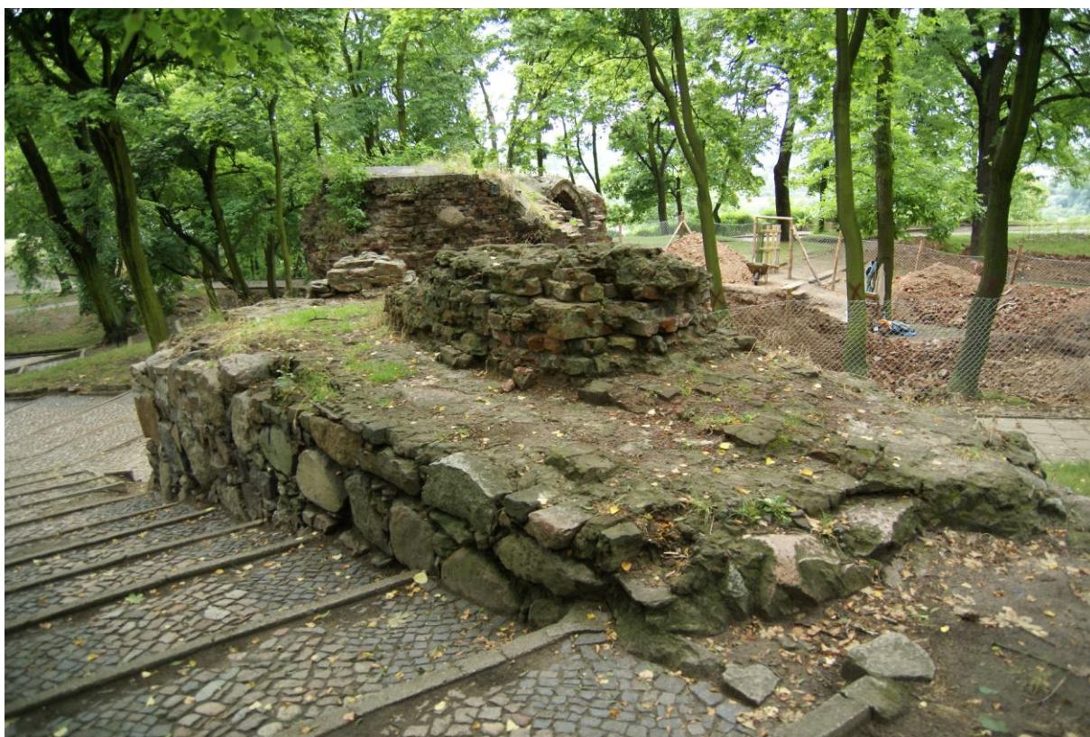
Odsadzka po stronie zewnętrznej. Służyła jako ganek do spiżarni. Do niej przylega dobudowana w latach 90. XIII w. kaplica zamkowa.
