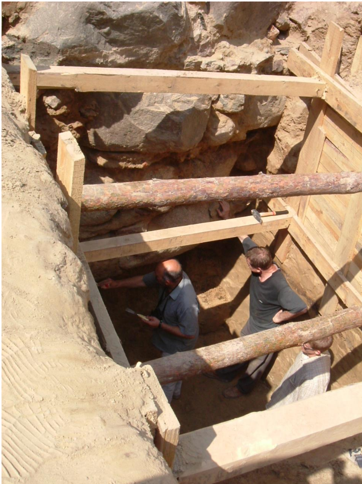
Fundament wieży Kłimek. Zdjęcie z 2007 r., wykonane podczas badań archeologicznych dr. Antoniego J. Pawłowskiego. Zewnętrzne lico wykonane z cegły maszynowej na przełomie. Dr Antoni J. Pawłowski wskazał na zdjęciu calec. Fundament dochodzi do wysokości jego ramienia. Wg dr. A. J. Pawłowskiego fundament kamienny w wątku opus incertum .
