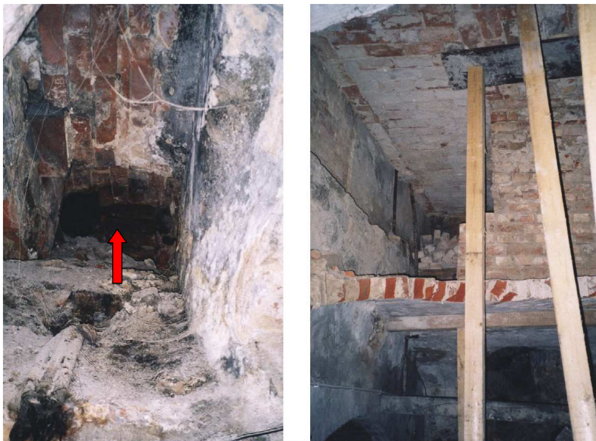
Ryc. 258. Okno na ścianie zachodniej piwnicy kamienicy przy ul. Murowej 21. Fot. M. Szajerka. Stan na przełomie 2002/2003 r. 13
