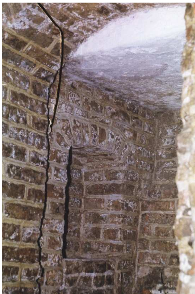
Ryc. 249. Piwnica kamienicy przy Rynku 20. Fot. M. Szajerka
