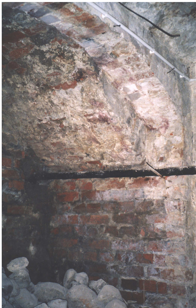
Ryc. 259. Portal gotycki w piwnicy kamienicy przy ul. Murowej 21. Fot. M. Szajerka. 15
