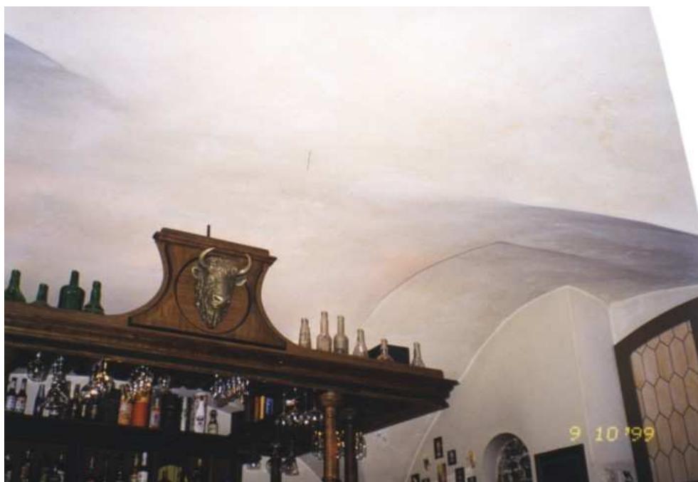
Ryc. 251. Ul. Wieżowa 2. Sklepienie krzyżowe w części mieszkalnej. Fot. M. Szajerka
