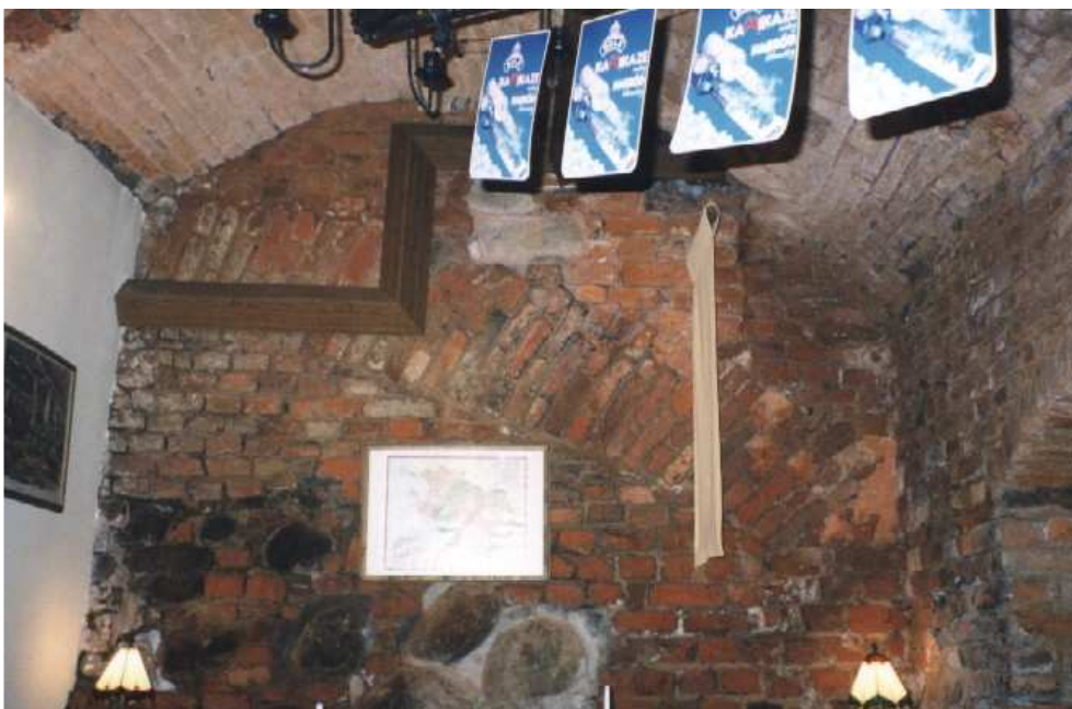
Ryc. 255. Fundament arkadowy na ścianie zachodniej piwnicy kamienicy przy ul. Wieżowej 2. Fot. M. Kucharski
