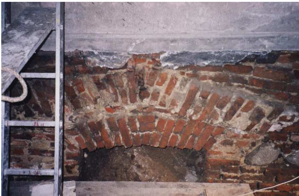
Ryc. 8. Zasypane drzwi w fundamencie zakrystii kościoła pojezuickiego. Stan w październiku 2003 r. fot. M. Szajerka.
