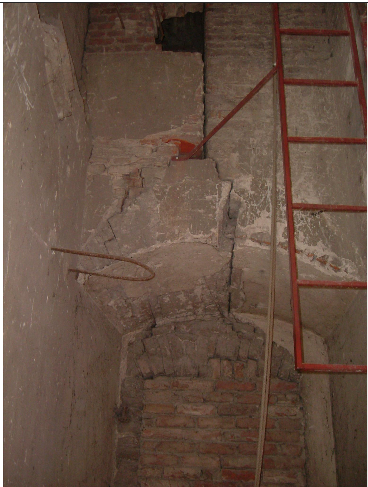
Wejście z parteru kolegium. Parter kościoła jest na poziomie suteryny kolegium.
