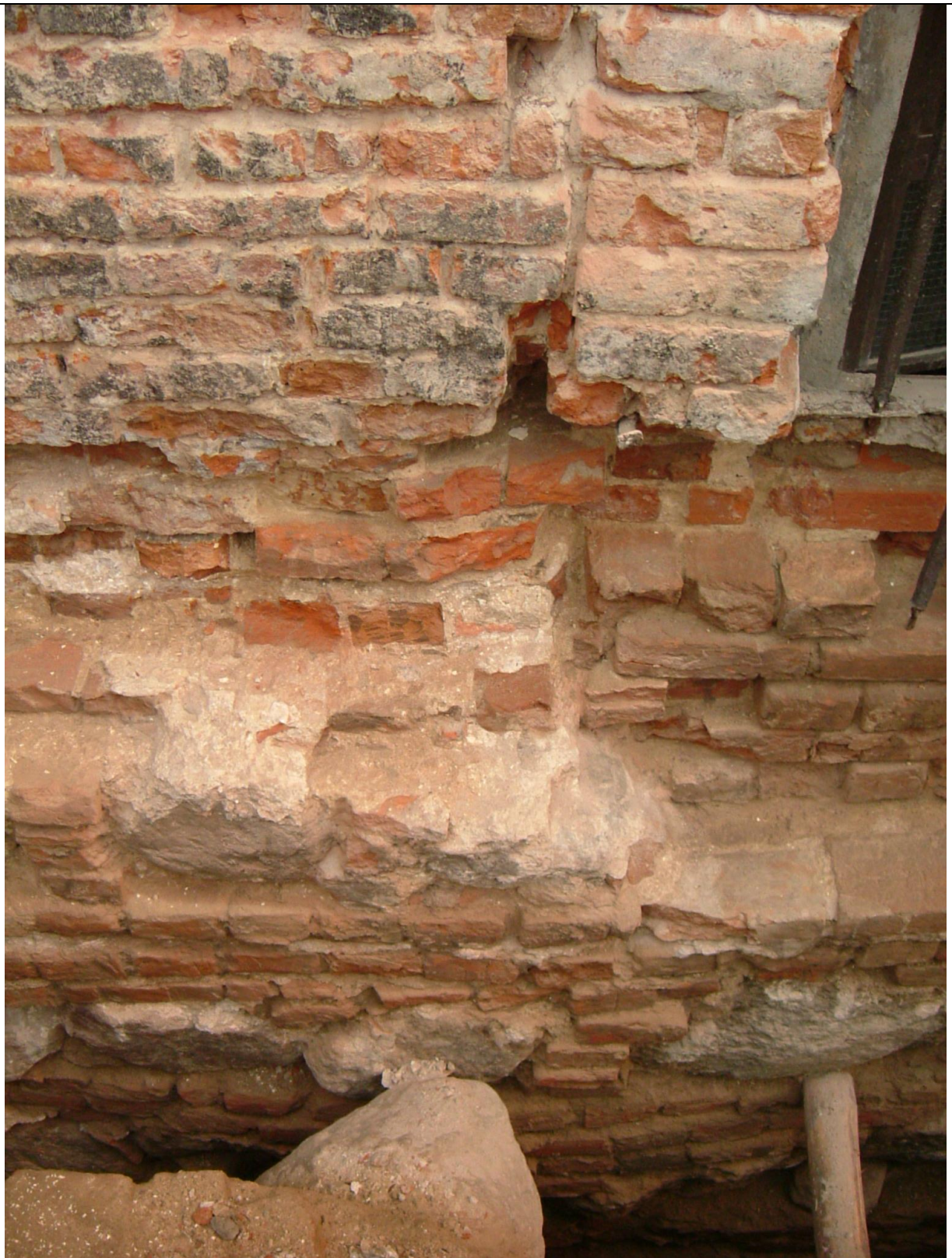
Wątek mieszany opus mixtum. Cegły wg klasyfikacji rozmiarów w kategorii romańskich z 1 poł. XIII w. Z identycznych cegieł wykonano zachowaną do naszych czasów romańska arkadę Mostu Bramy Toruńskiej.
