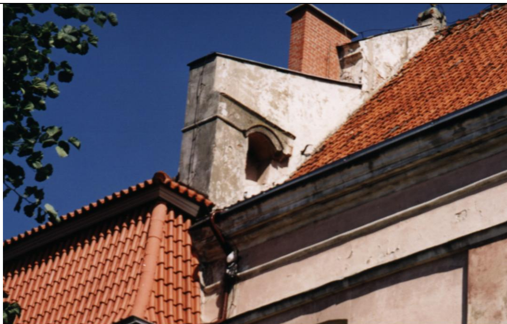
Okno , pozostałość po zredukowanej wysokości Bramy Klasztornej.
