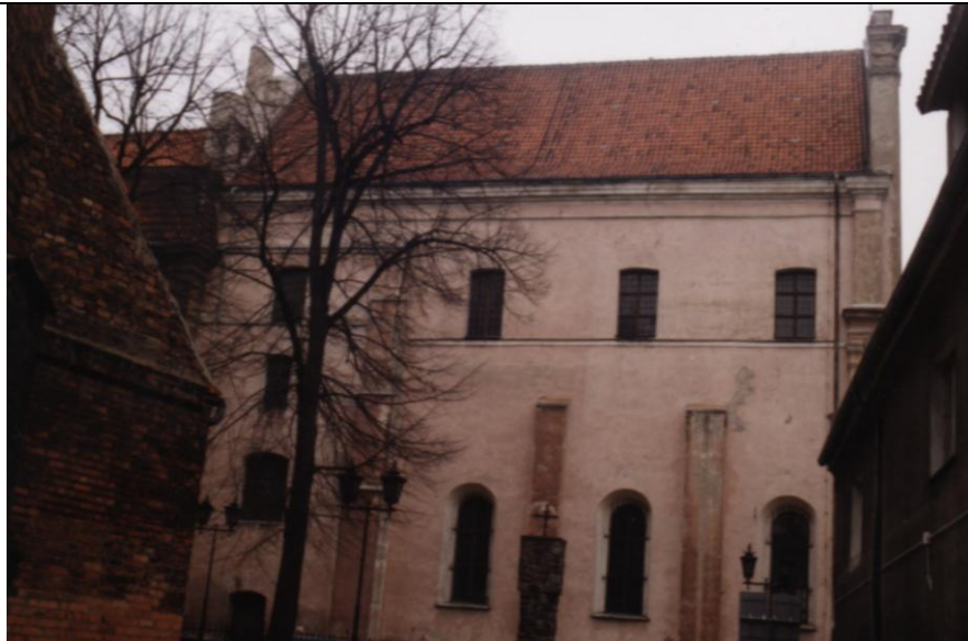
Na tym zdjęciu widać rozbudowę obiektu . Górne okna nad gzymsem pochodzą z początku XVIII w. Po lewej stronie fasada Bramy Klasztornej.
