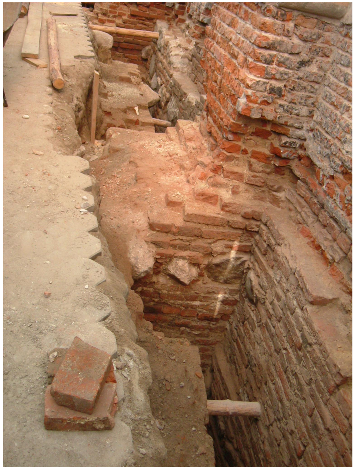
Fundament kościoła. Po odkopaniu okazuje się, że widoczne na powierzchni lizeny okazują się przyporami uskokowymi. Do fundamentu kościoła prawie przylega mur niewiadomego przeznaczenia o grubości około 2 m. Cegły z tego wykopu są identyczne, jak cegły ścian zakrystii kościoła św. Mikołaja.
