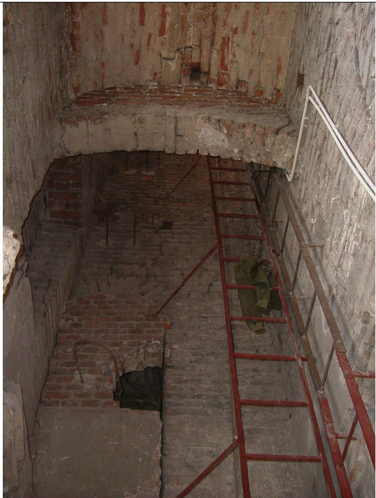
Ściana zachodnia. Widoczne drzwi prowadziły do gmachu kolegium. Po prawej stronie ściana prezbiterium.
