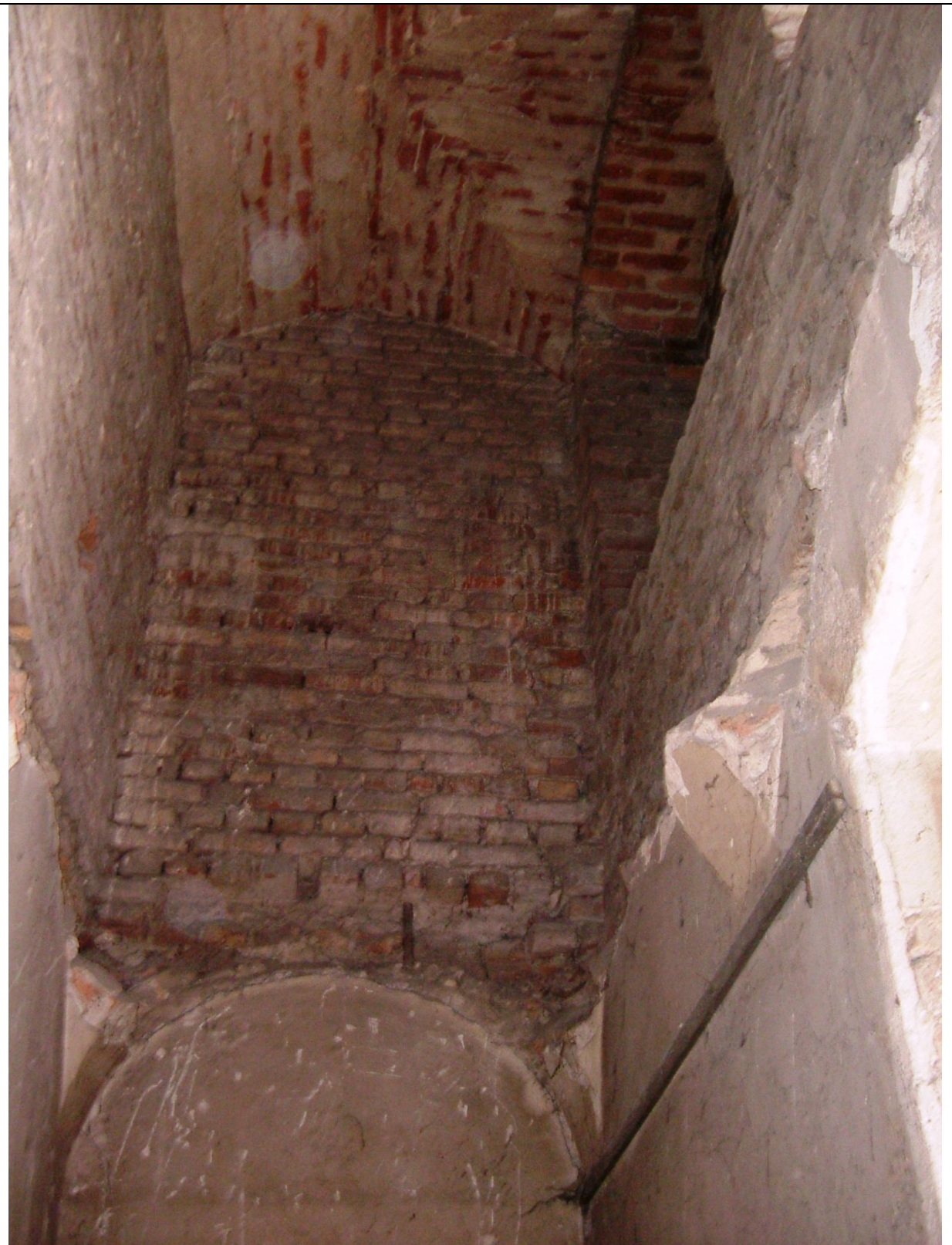
Wnętrze dawnej Bramy Klasztornej, zdjęcia z 2006 r. Widoczne na zdjęciu ślady sklepienia, które zostało zniszczone w trakcie działań wojennych w 1945 r. i nie zostało odtworzone. Chór - ściany wschodnia i południowa
