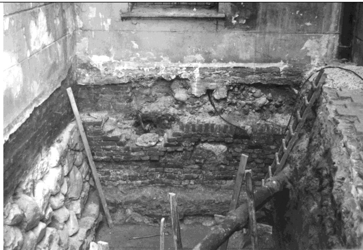
Wykop pod windę. Początek XXI w. Po lewej stronie kamienny fundament baszty osłaniającej od południowego zachodu Bramę Klasztorną. Obecna klatka schodowa Ratusza nie ma nic wspólnego ze średniowieczem. Tylko jest na średniowiecznym fundamencie.
