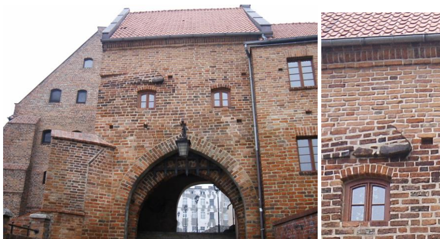
Fot. 8. Brama Wodna, stan współczesny . Z prawej strony kadr ujęcia gzymsu, śladzie po wykuszu „nosowym”. Fot. M. Szajerka.
