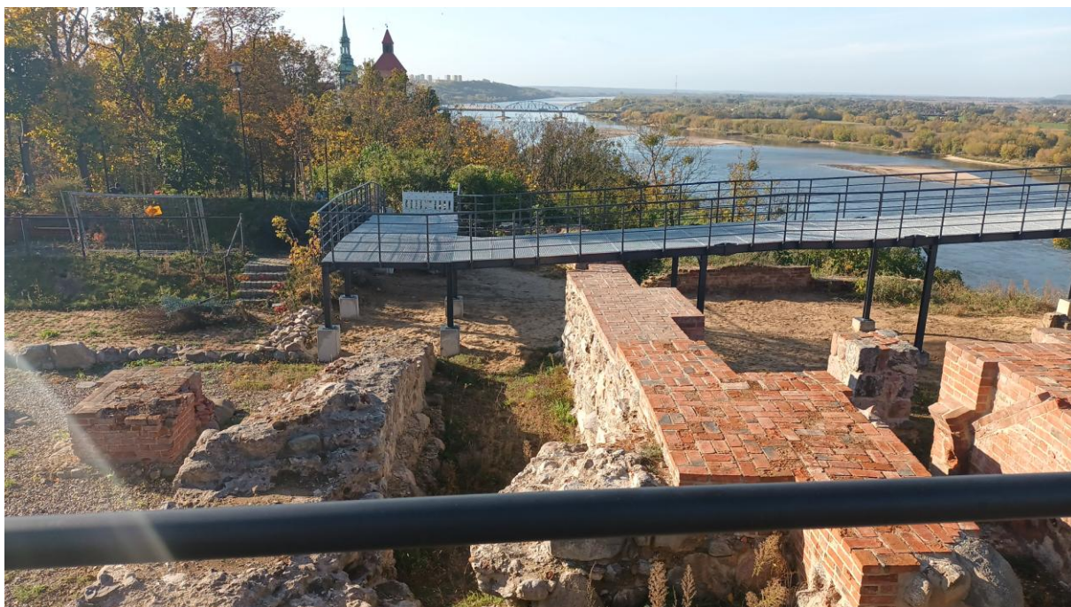
Rozebrana ścianka działowa po zamontowaniu pomostu. Stan w 2024 r.
