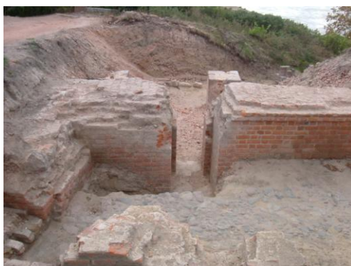
Ryc.14. Piwnice w części południowo-zachodniej. Po lewej stronie schody do tunelu bramnego. Stan z 25.09.09. Fot. M. Szajerka.
