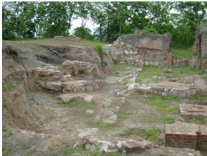
Ryc.33. Widok na ścianę wschodnią skrzydła południowego. Widoczna częściowa niwelacja terenu za tą ścianą w porównaniu ze stanem na zdjęciu z 14.12.2008 r. Stan z 25.05.2010 r. Fot. M. Szajerka.
