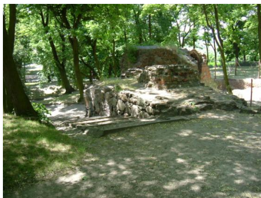
Ryc.65. Odsadzka w ścianie wschodniej skrzydła południowego, po jego zewnętrznej stronie. Jest to pozostałość po posadzce kaplicy zamkowej. Stan z 8.06.2008 r. Fot. M. Szajerka.
