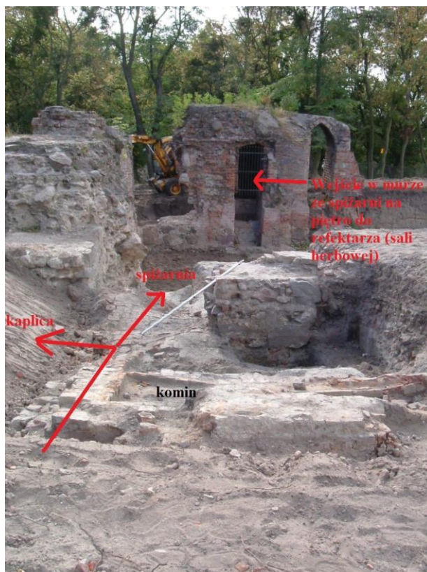
Ryc.34. Ganek po stronie wschodniej, wyłożony cegłą przy skrzydle południowym. Na pierwszym planie widoczny fundament komina. Strzałkami zaznaczone wejścia do kaplicy na lewo oraz do spizarni na wprost. Stan z 25.09.2009 r. Fot. M. Szajerka.
