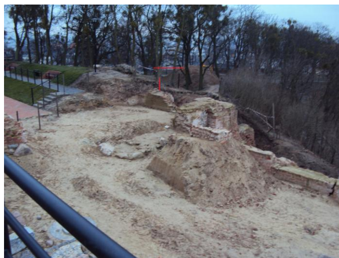
Ryc.16. Próg bramy wjazdowej. Zdjęcie z 16.12.2014 r. Fot. M. Szajerka.
