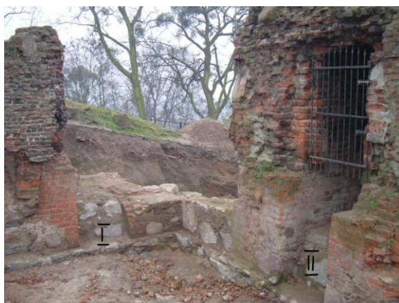
Ryc.45. Wejścia do piwnicy pod spiżarnią. Oznaczenia: I - wejście z narożnika wschodniego skrzydła południowego; II -wejście z ganku w murze ściany południowej. Stan z 6.12.2008 r. Fot. M. Szajerka.
