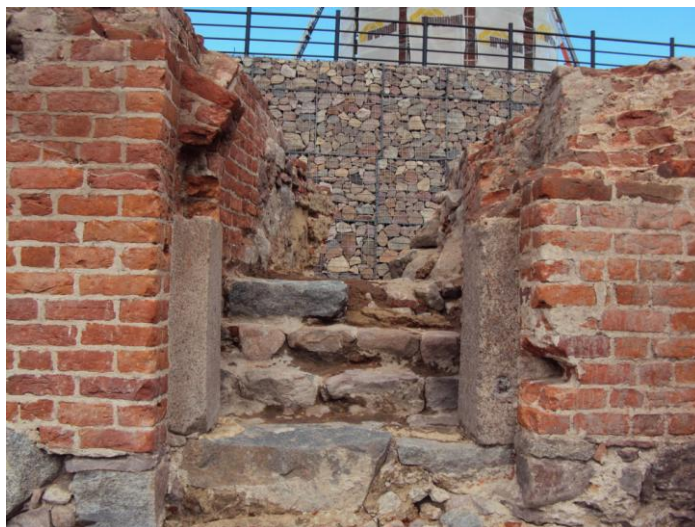
Ryc.17. Schody przy tunelu bramnym. Stan w lipcu 2014 r. Fot. M. Szajerka.
