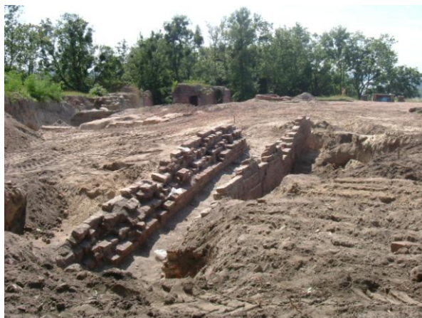
Ryc.35. Widok na ruiny skrzydła południowego od strony kanału ściekowego kuchni po stronie północnej. Zdjęcie pokazuje różnice poziomów oraz brak śladów muru kurtynowego. Stan 3.08.2009 r. Fot. M. Szajerka.
