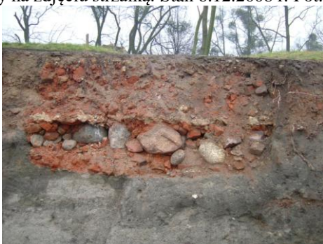
Ryc.29. Fundament poza linią ściany wschodniej skrzydła południowego. Stan 6.12.2008 r. Fot. M. Szajerka.
