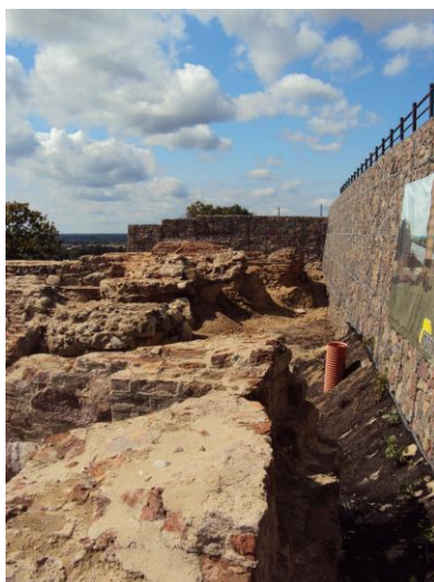
Ryc. 67. Relikt fundamentów fasady północnej skrzydła południowego. Stan 14.08.2014 r. fot. M. Szajerka.
