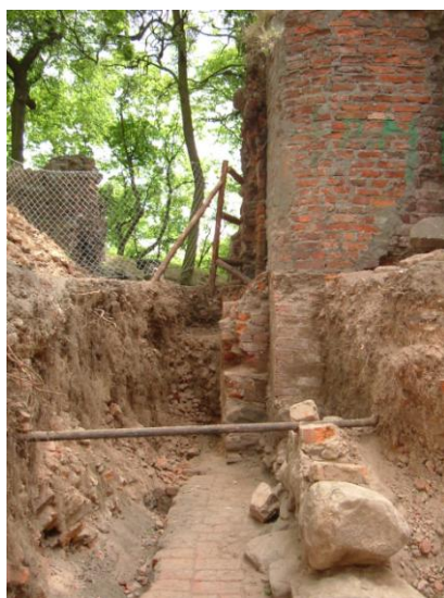
Ryc.66. Odsadzka w fundamencie ściany południowej skrzydła południowego na poziomie piwnicy. Stan 22.06.2008 r. Fot. M. Szajerka.
