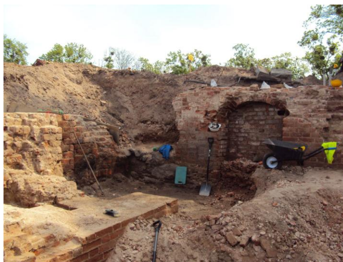
Ryc.18. Wnęka w murze. Stan w maju 2014 r. Fot. M. Szajerka
