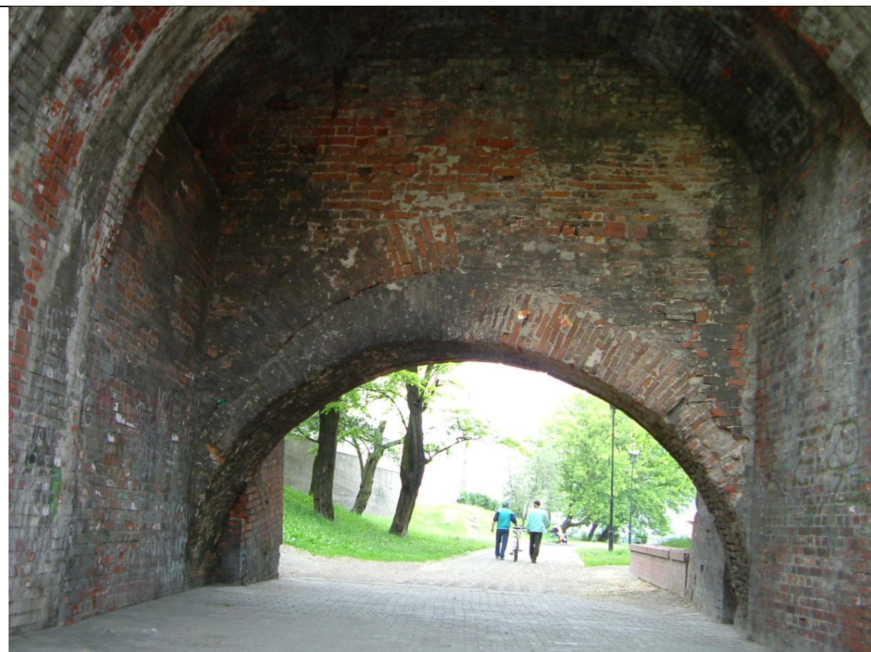
Most Bramy Toruńskiej . Widok od strony wschodniej . Łuk dolny z cegieł romańskich. Część po lewej stronie naprawiana w latach 30 -40 XVIII w. W tym miejscu była grobla, spiętrzająca wodę dla urządzenia wodociągowego.
