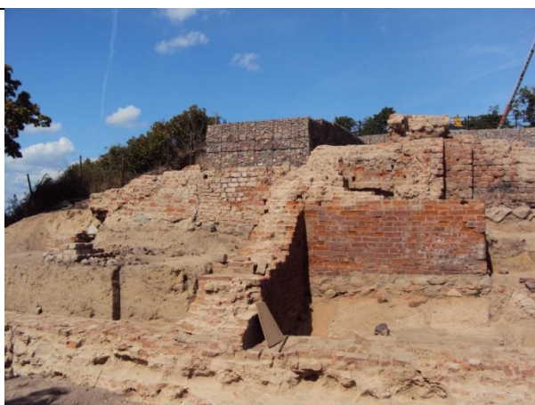
Strona północna tunelu bramnego, na poziomie ok. 59-60 m n. p.m.
