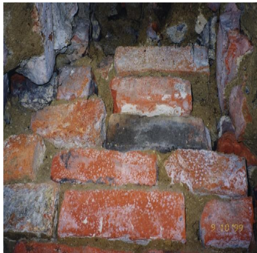
Relikt przewodu kominowego
